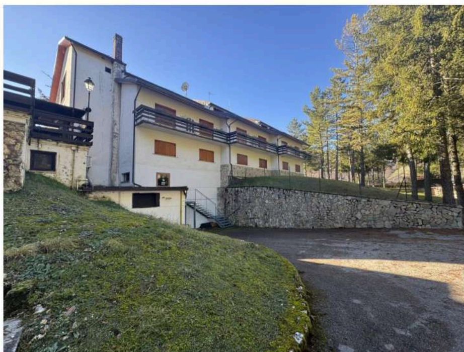
- vista posteriore dell'immobile
