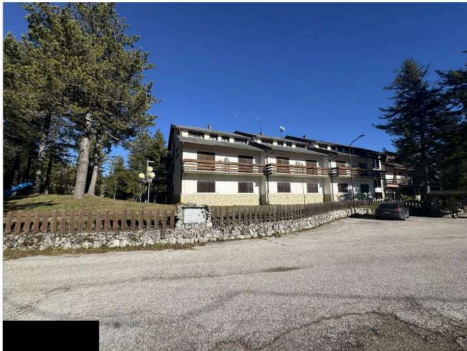
- vista dell'immobile fronte principale
