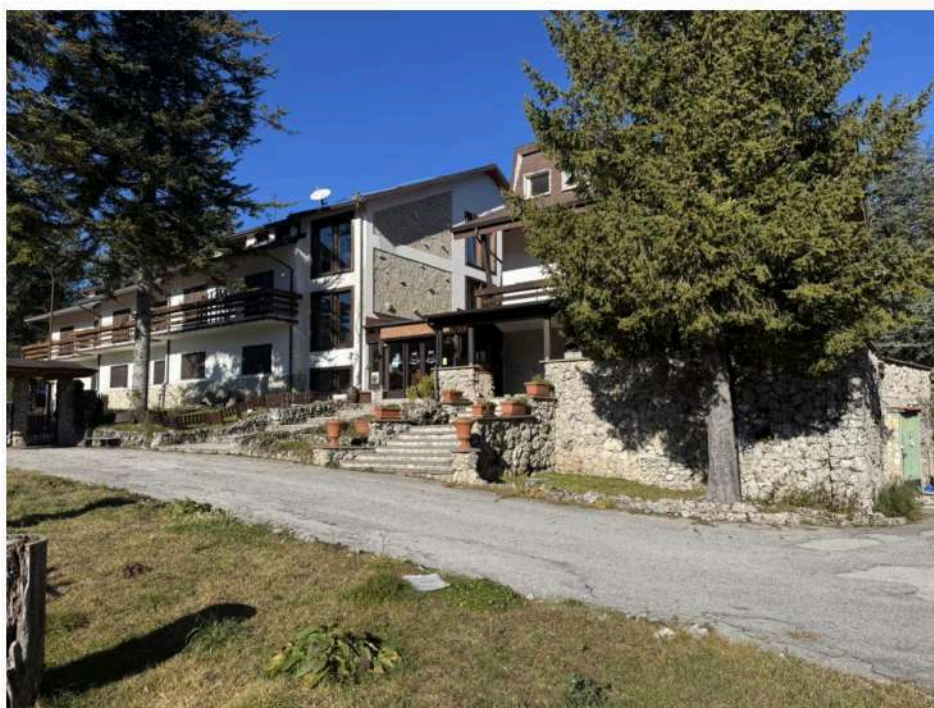
- vista laterale dell'immobile fronte principale
