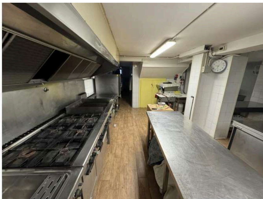
- Piano S1 – cucina ristorante (zona villa preesistente)
